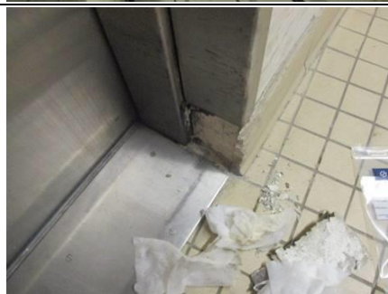
Photo n° PhA006 Localisation : N-1 - Ascenseur 49; N 0 - Ascenseur 49 Ouvrage : 5 - Planchers et planchers techniques - Revêtements de sols Partie d'ouvrage : Colle de carrelage Description : SOL : Colle de carrelage Localisation sur croquis : ZPSO-009
