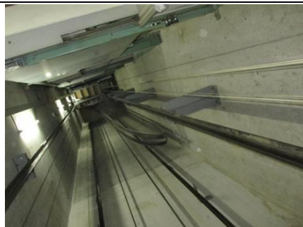
Photo n° PhA005 Localisation : Ascenseur 49 - Cage; Ascenseur 50-51 - Cage; Ascenseur 52 - Cage Ouvrage : 4 - Plafonds et faux plafonds - Plafonds Partie d'ouvrage : Enduit à base de ciment projeté Description : PLAFOND : Enduit à base de ciment Localisation sur croquis : ZPSO-007
